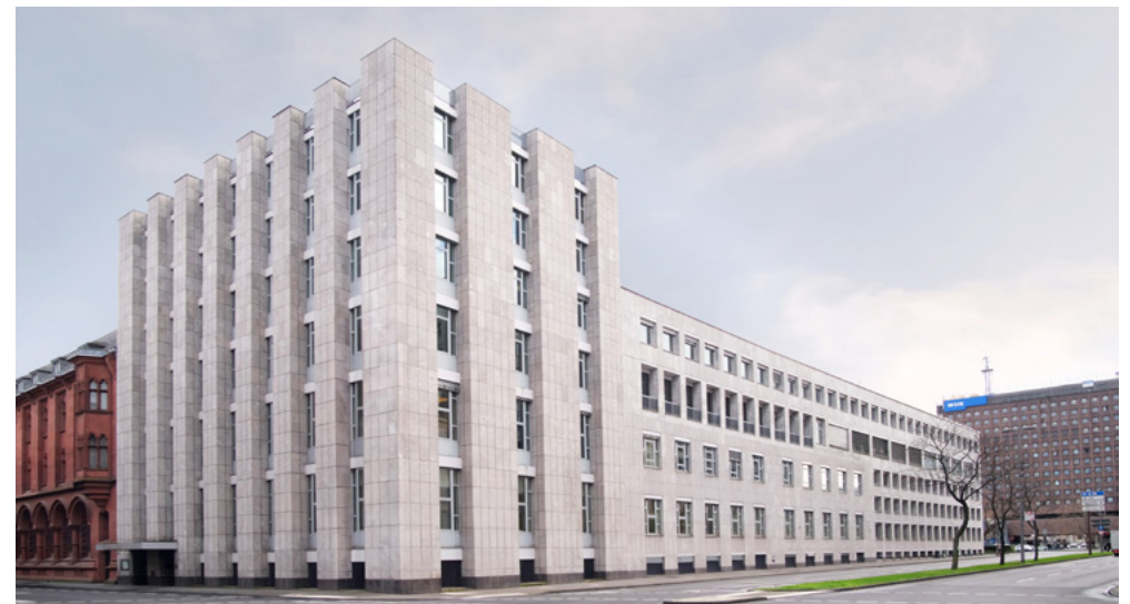
Die IHK zu Köln mietete das bislang von der Commerzbank genutzte Bürogebäude Unter Sachsenhausen 5-7.
