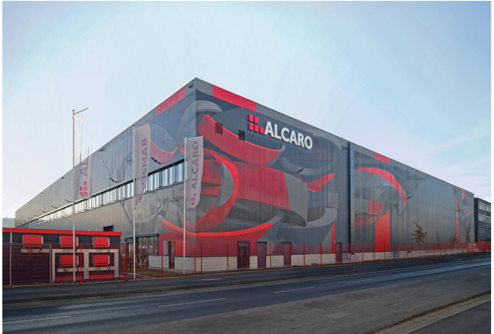
Das Log Plaza Colonia 2 in der Poll-Vingster-Straße 126-128 wurde 2023 mit rund 12.000 Quadratmetern Halle fertiggestellt und 2024 von Alcaro Invest an CBRE IM veräußert.
