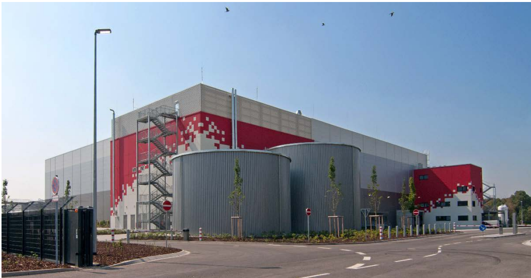
Neubaubjekt in Köln Niehl © Greif & Contzen 2018
